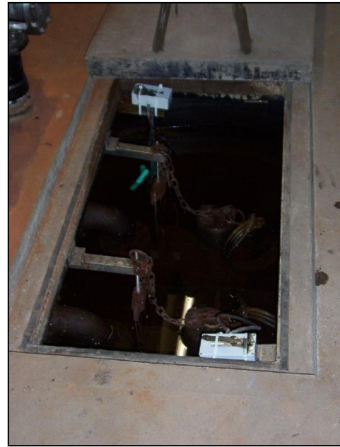
Abbildung 3 und 4: Kontrollgang und Pumpensumpf in der Mitte des Kontrollganges
